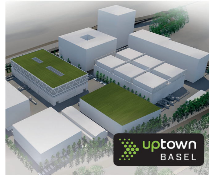
Auf dem Schorenareal entsteht das neue Kompetenzzentrum für Industrie 4.0
