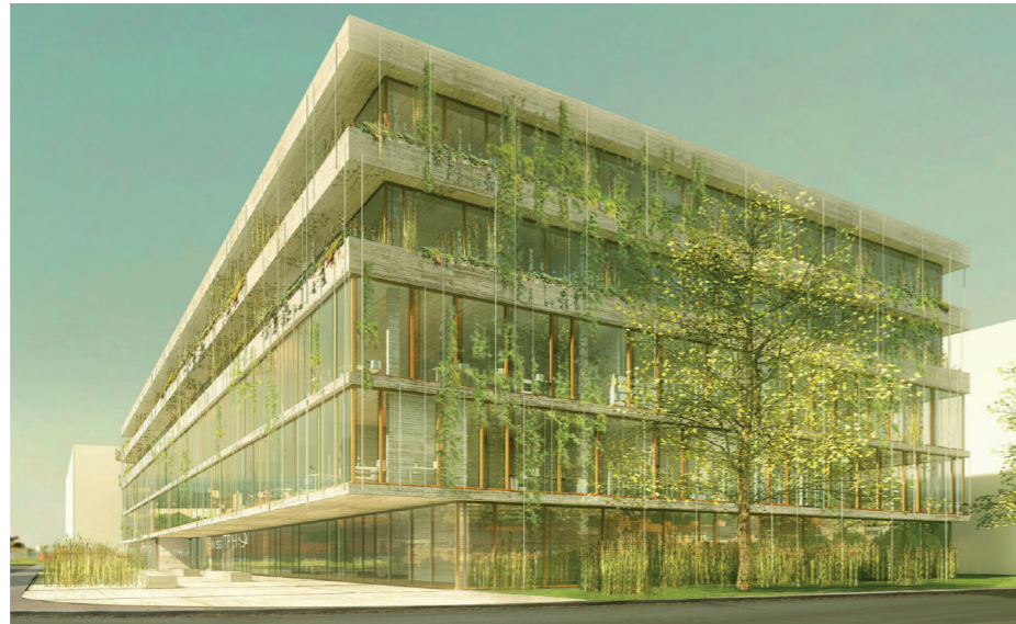
Das Architekturbüro Kunz und Mösch aus Basel gewinnt den Wettbewerb für den Neubau des Swiss TPH.
