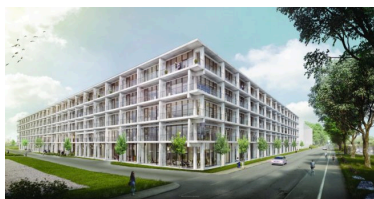
Bas Bauprojekt GRID auf dem BaseLink Areal in Allschwil. Bild zVg
